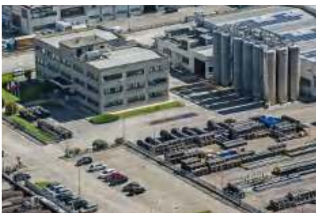
Centro Operativo - Castel Guelfo di Bologna (BO)
